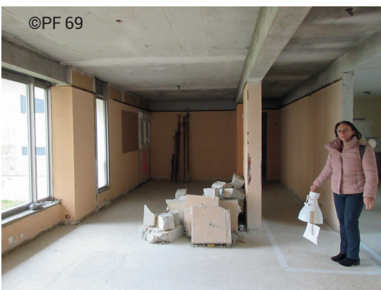
Nath, chantier du local du Tonkin, 2019.
